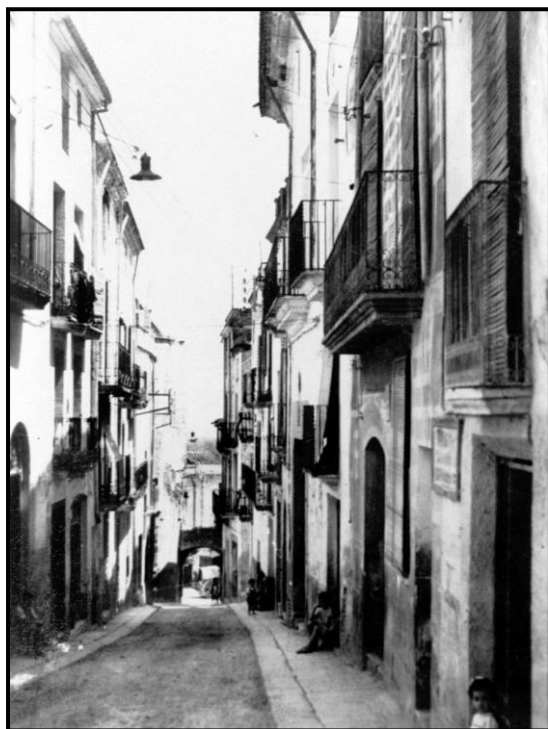
Actual carrer Major
