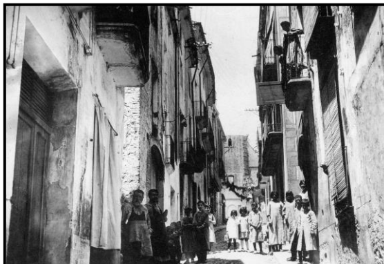
Actual carrer Major
