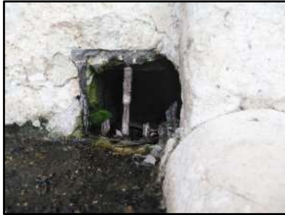
Desguàs de la font que cal reparar
