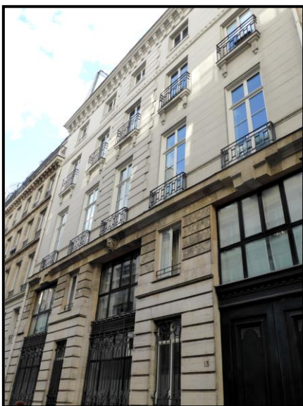
Edifici on estava l’Hôtel Rouen
